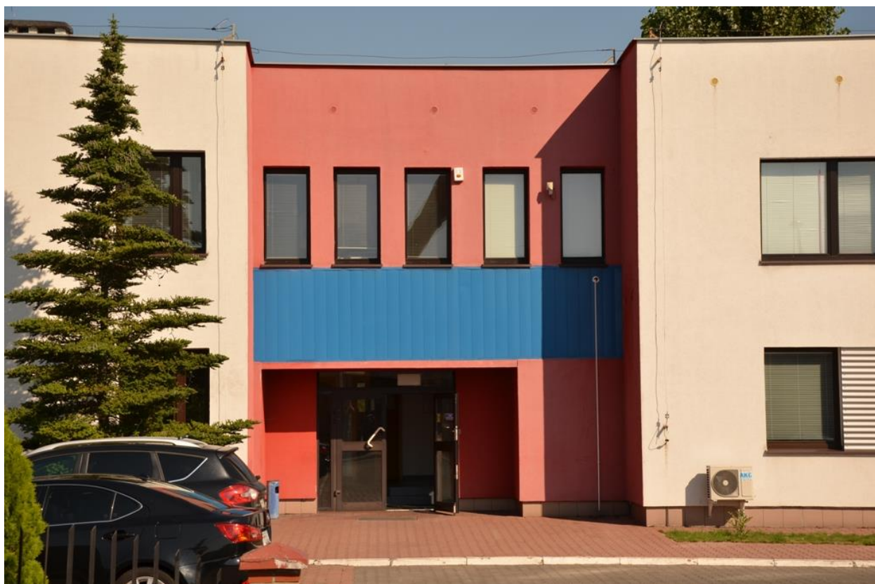
Wejście boczne do budynku administracyjnego
